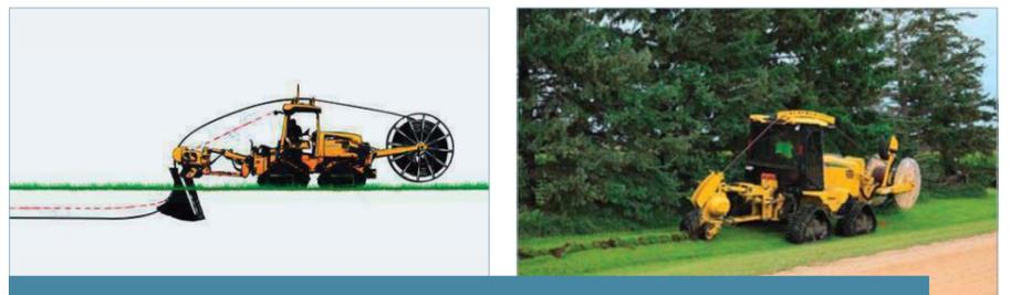
Abb. 4: Einpflügen eines Mittelspannungskabels. Dabei spalten ein Schwert und ein Aufweitkopf das Erdreich, um das zu verlegende Rohr einzulegen. Mit der Zeit drückt sich das geweitete Erdreich um das Rohr wieder zusammen.
