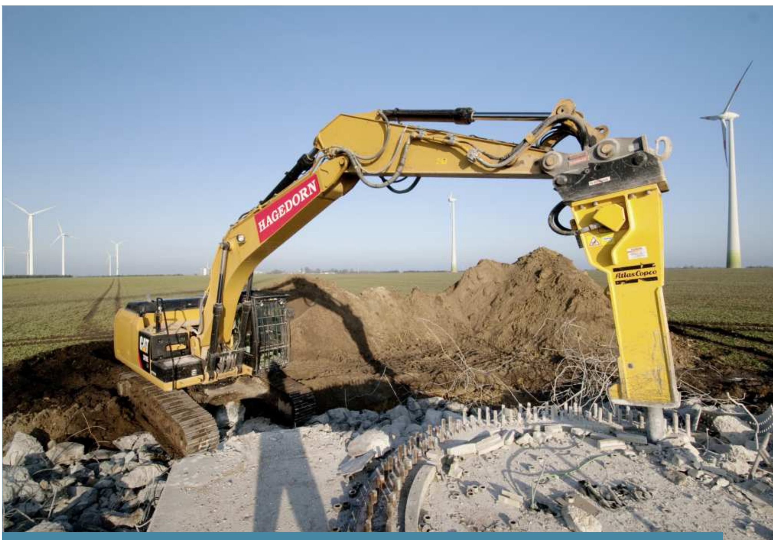
Abb. 1: Rückbau eines Windenergieanlagenfundamentes. Quelle: Firma Hagedorn Recycling.
